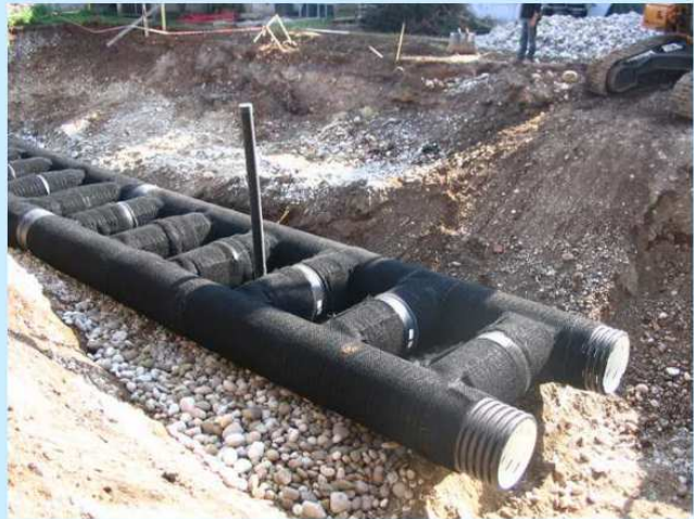
Tubi corrugati in polietilene fessurati per il contenimento dei volumi d'acqua
