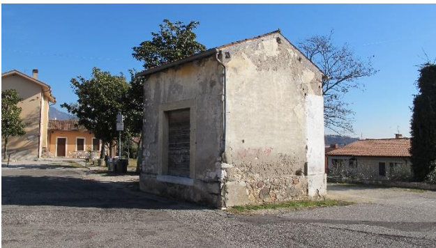
Intonaco base calce con terra del veronese Torricelle o Ponte di Veja giallo dorè
