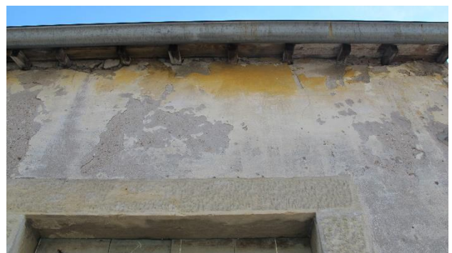
Intonaco base calce con terra del veronese Torricelle o Ponte di Veja giallo dorè
