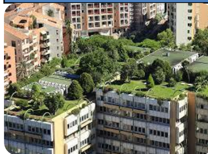
Coperture a verde
